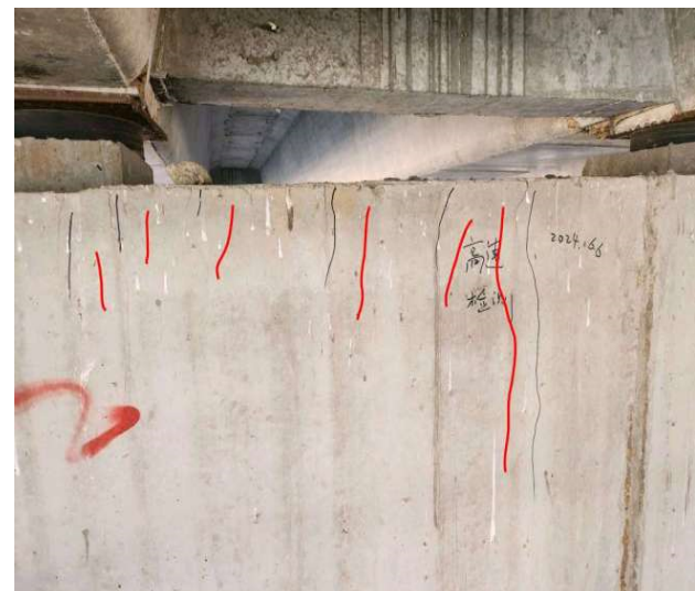
1) 盖梁混凝土裂缝
