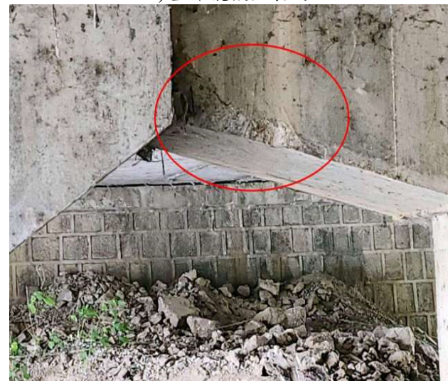
3) 盖梁混凝土破损
