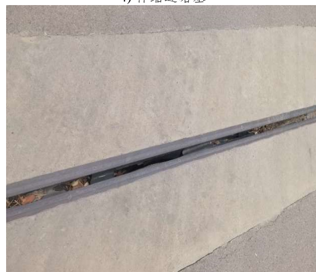
6) 伸缩缝橡胶带破损
