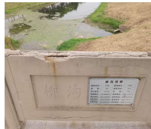
9) 栏杆破损、露筋
