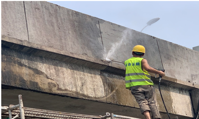
图 6-1 高压水射流清洗
