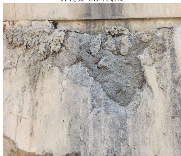
3) 混凝土破损
