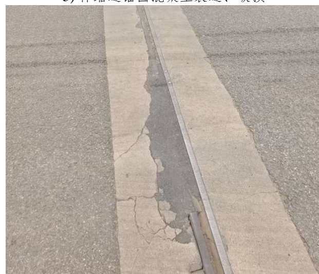
7) 伸缩缝松动、焊缝开裂
