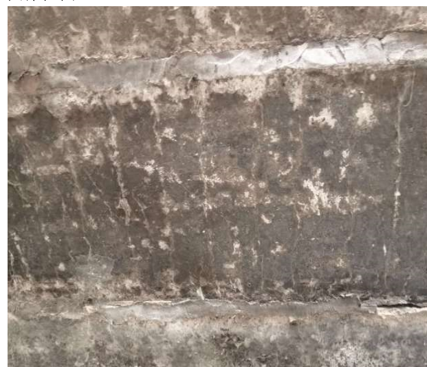
2) 混凝土横向裂缝
