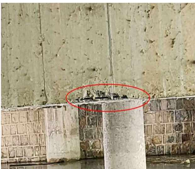
5) 盖梁锈胀、露筋
