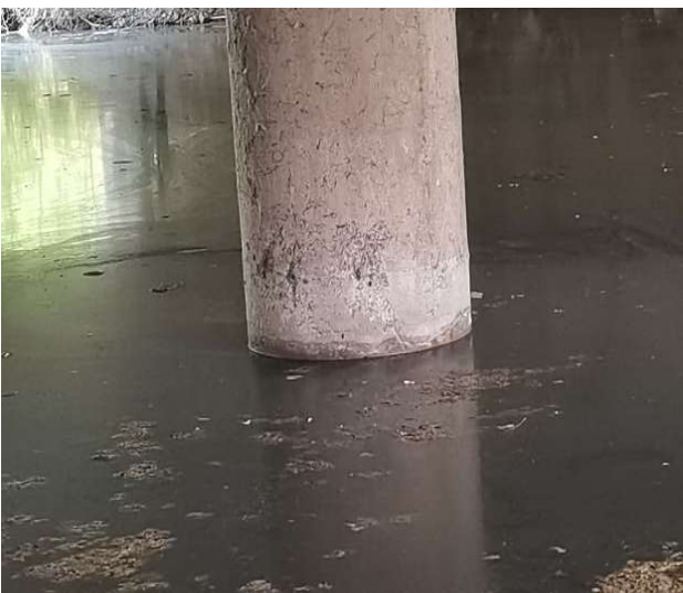
2) 桥墩混凝土破损
