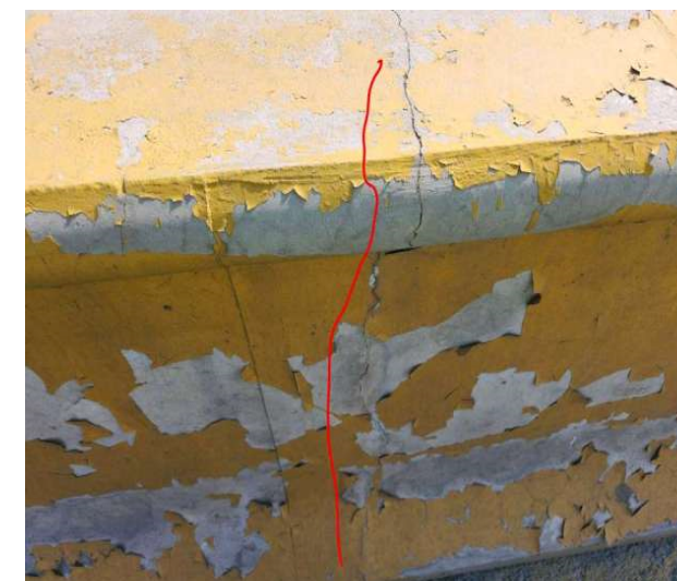
10) 护栏裂缝
