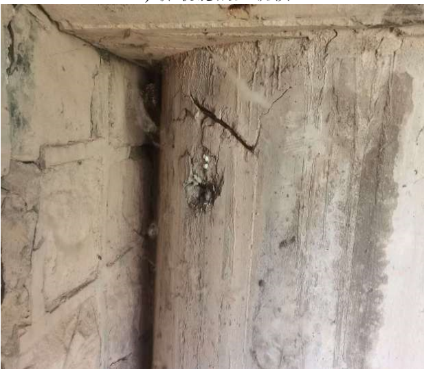
4) 桥墩锈胀、露筋
